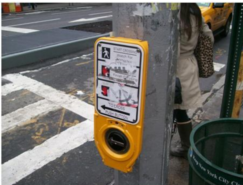
Foto 25 - Detalhe de botoeira para deficientes visuais
