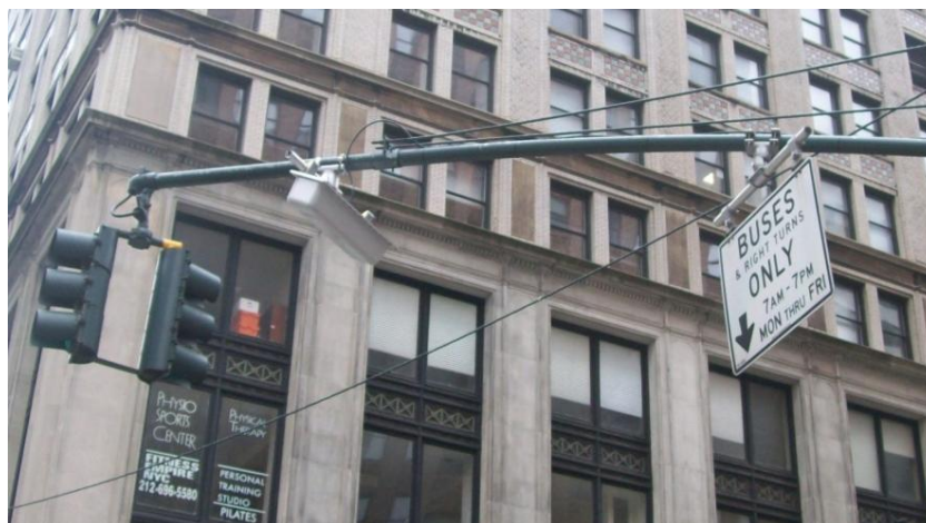
Foto 50 – Placa presa somente pela borda superior
