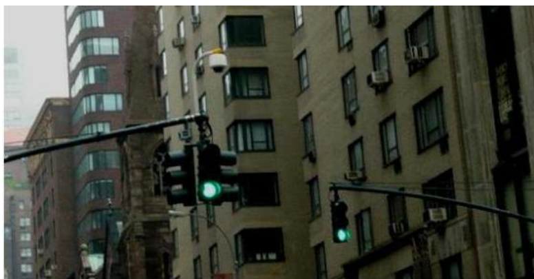
Foto 44 – Câmera montada sobre o próprio grupo focal
