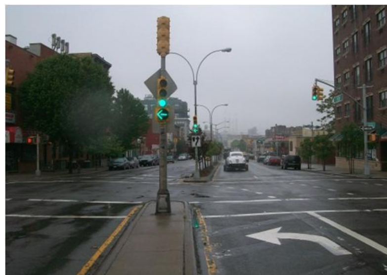
Foto 19 - Grupo focal na indicação verde para o movimento direto em frente e na indicação verde seta para o movimento de conversão com preferência
