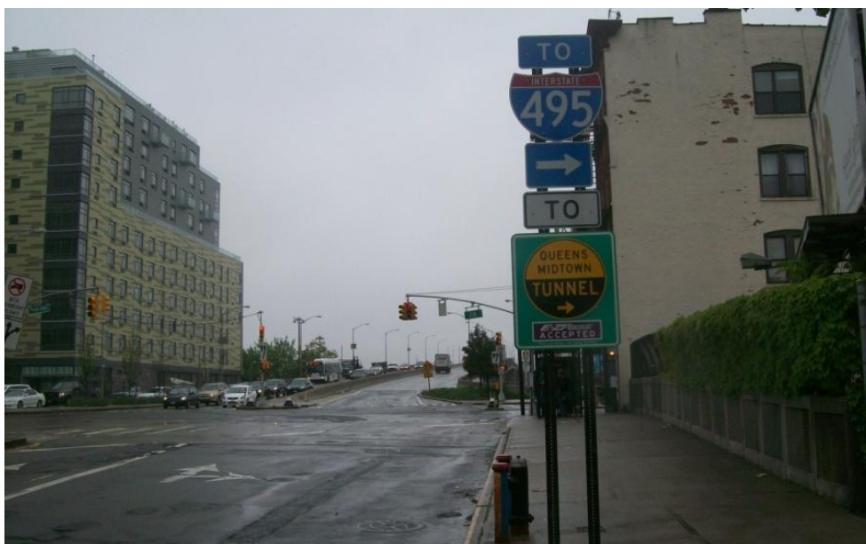
Foto 53 – Excesso de sinalização numa mesma coluna
