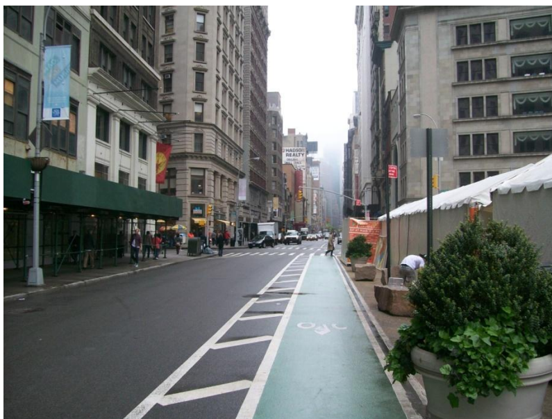
Foto 27 – Via protegida para bicicleta
