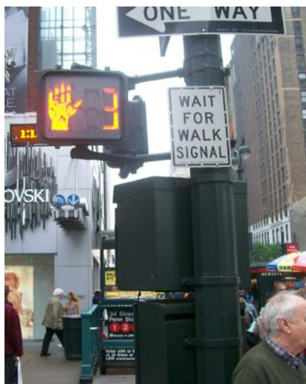
Foto 10 Intervalo de vermelho intermitente com o contador regressivo,
