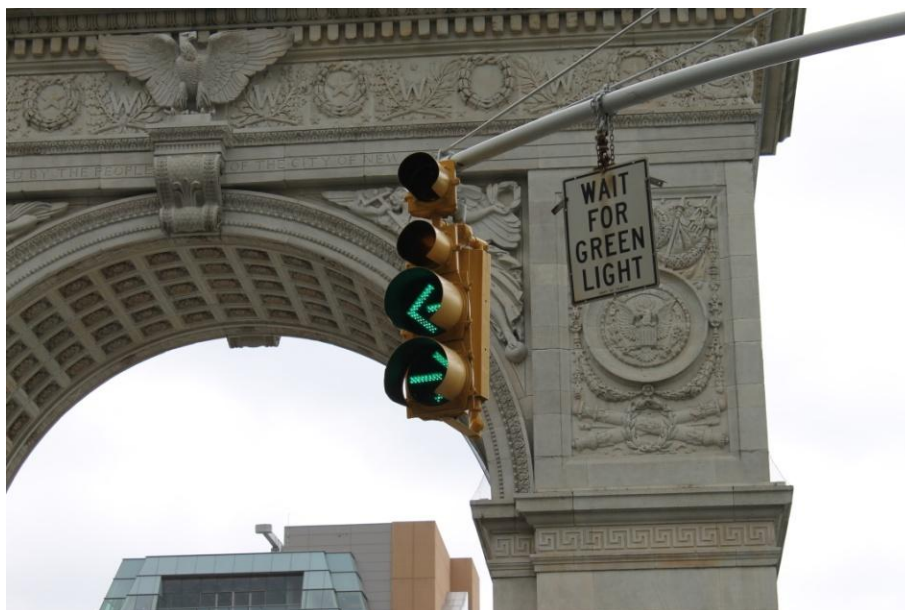
Foto 47 – Grupo focal com setas para a esquerda e direita
