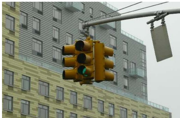
Foto 43 – Um só braço projetado sustentando três grupos focais
