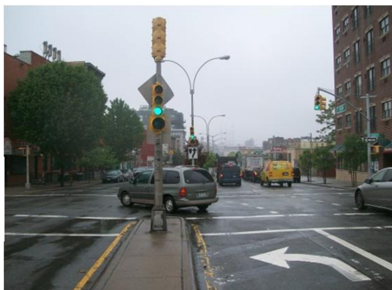
Foto 18 – Grupo focal na indicação verde tanto para o movimento direto em frente como para o movimento de conversão sem preferência
