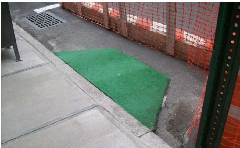
Foto 57 – Rampa provisória para pedestres durante fase de obra
