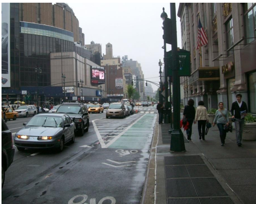
Foto 30 – Estacionamento entre ciclofaixa e trânsito geral
