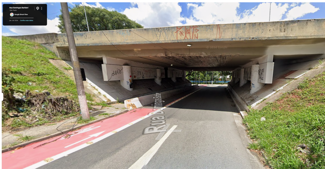
Figura 2 - Imagem do trecho da rua Domingos Barbieri sob a rodovia Raposo Tavares.
